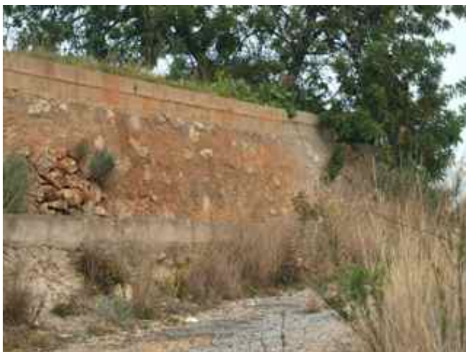
Foto 1 . Entrador des del Camí de La Vilavella a la finca dita de 'La Torreta'.
