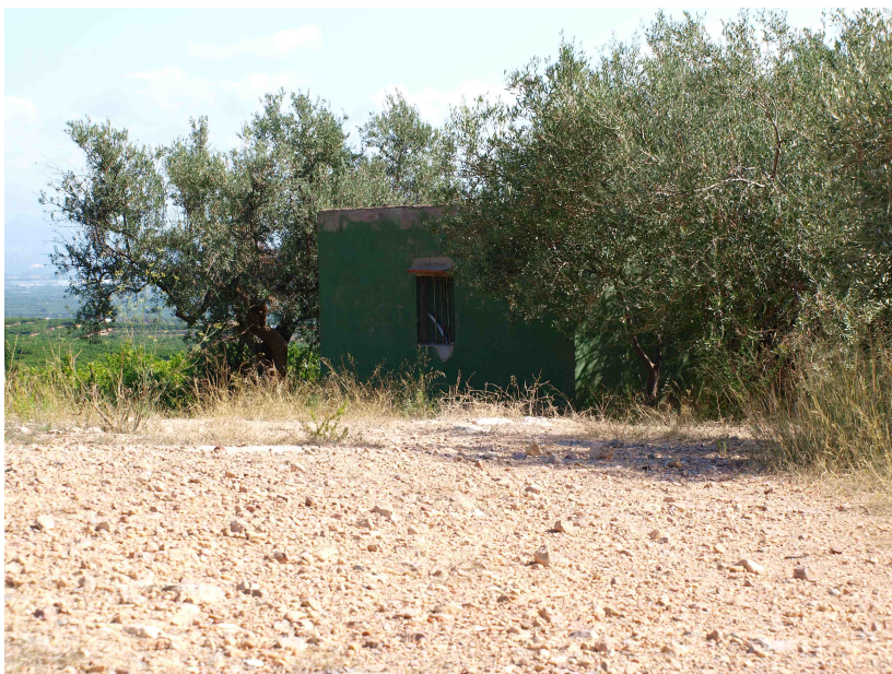
Foto 5.- La caseta pintada de verd, d'una sola planta, de construcció recent, situada dalt del turó, voltada d'oliveres. En primer pla, terra nova duta recentment.
